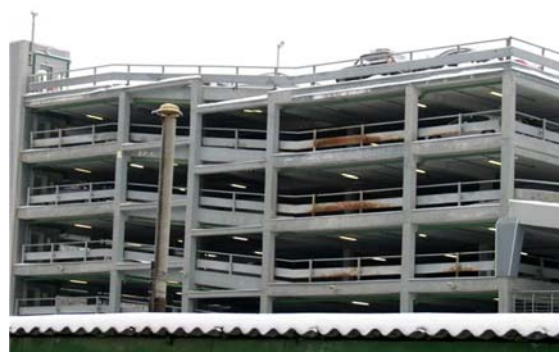
Một ga-ra nhiều tầng đang được xây dựng ở Matxcova
